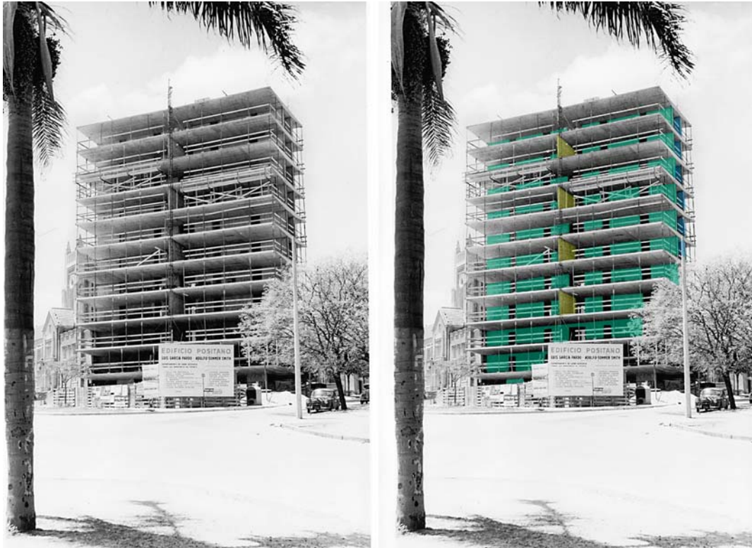
Foto de obra en donde se evidencia la construcción de la estructura de forma idéntica a lo especificado en los planos.
